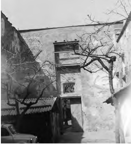
FIG. 1. Montecatini Terme, Italy; nave of the former church of Santa Margherita (Archivio fotografico della Soprintendenza per i Beni Architettonici, Paesaggistici, Storici, Artistici ed Etnoantropologici per le provincie di Firenze, Prato e Pistoia, 20-12-1973).
